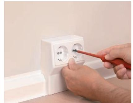
Geräteblende inkl. Schraube in die Öffnung des Gerätetanks setzen und festschrauben.
